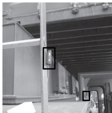
(d) Installation of N/D for Multi-Hop Test
